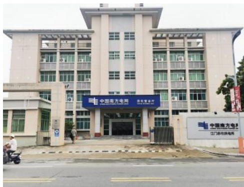
图 2. 崖口村中国南方电网标牌
